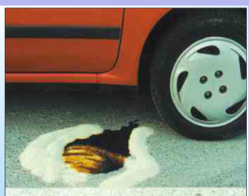
Mantenimiento de carreteras
